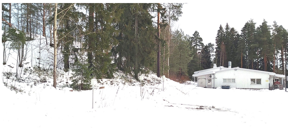
Päiväkodin pohjoispääty ja harjannetta
